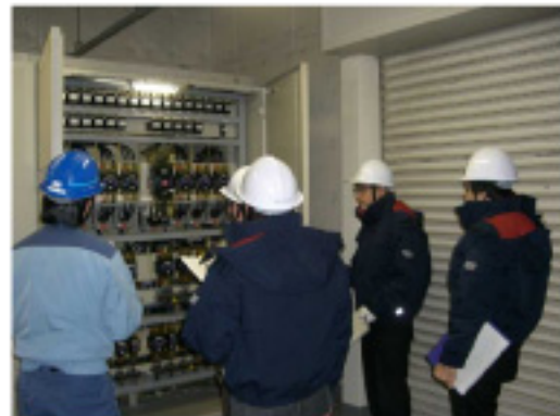
電気室点検状況
