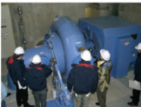
水力発電設備点検状況
